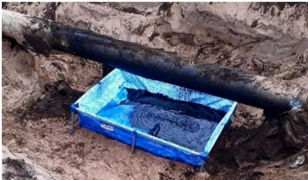
**Imagen 2:** Contención mediante pileta de lona del derrame de petróleo producido por fisura en un oleoducto troncal de Oldelval, en el tramo Medanito-Puesto Hernández, provincia de Río Negro.
